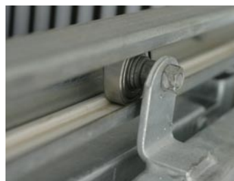
Dörrlagring upptill löper lätt i skena.
