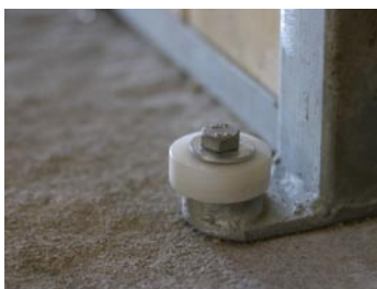
Lagring under dörr för tyst gång.
